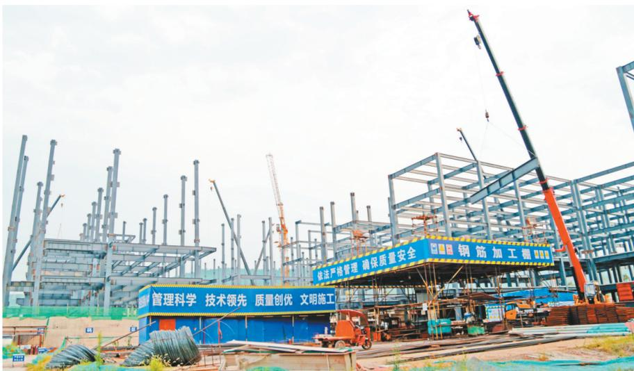
近日,县工业园区12万平方米标准厂房项目建设现场,工人在吊装钢结构。
