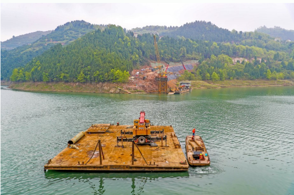
忠石沿江旅游公路正在紧张建设中。
