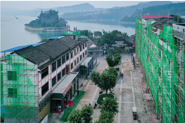
石宝镇(旅游街)环境综合整治(一期)项目建设现场。
