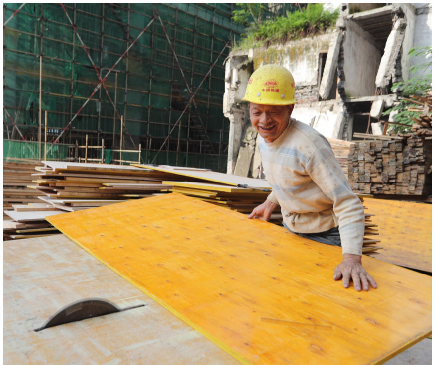
5月2日,鸣玉溪棚改区重建房施工现场,工人在加工模板。
