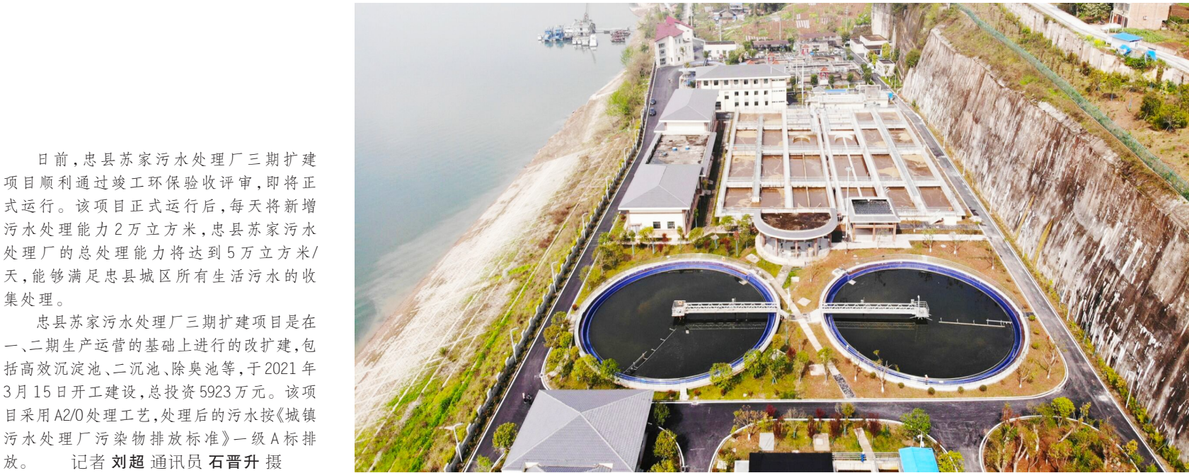
日前,忠县苏家污水处理厂三期扩建项目顺利通过竣工环保验收评审,即将正式运行。该项目正式运行后,每天将新增污水处理能力2万立方米,忠县苏家污水处理厂的总处理能力将达到5万立方米/天,能够满足忠县城区所有生活污水的收集处理。
