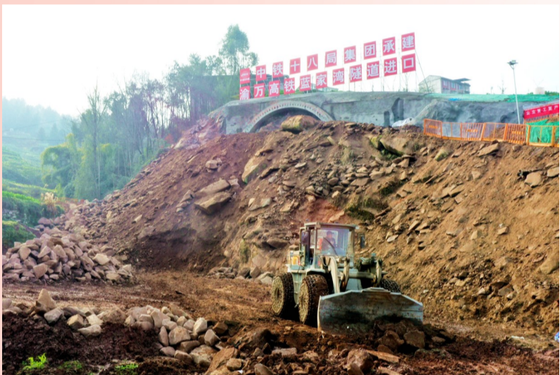
中铁18局渝万高铁站前工程2标蓝家湾隧道进口完成洞口截水沟、隧道导向墙和管棚施工,即将开始正洞爆破施工。
