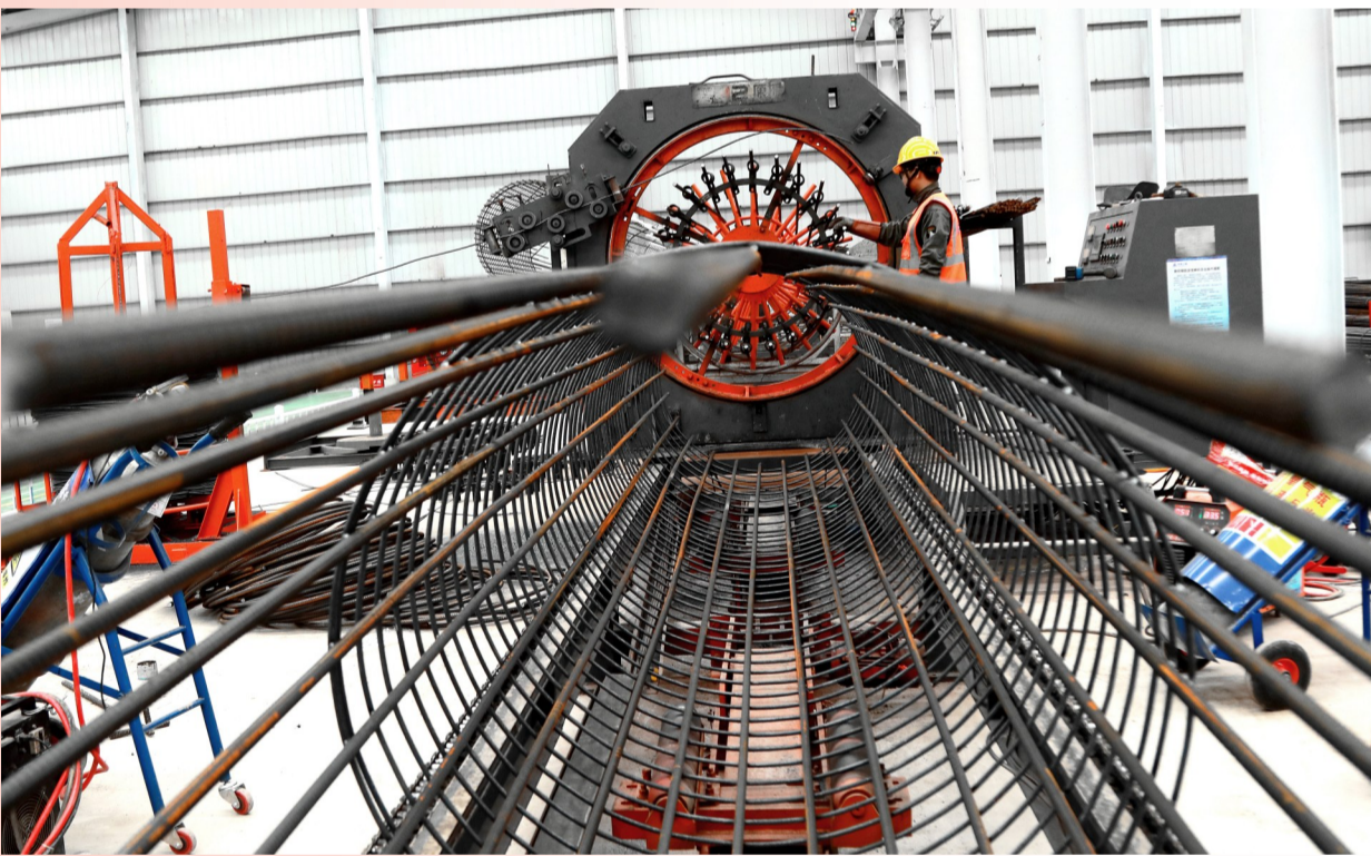
中铁3局渝万高铁站前工程3标2号钢构厂建成投用。
