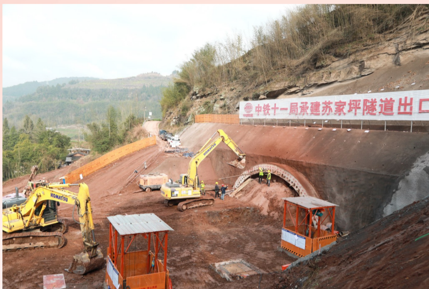
中铁11局渝万高铁站前工程1标苏家坪隧道工程即将进洞施工。
