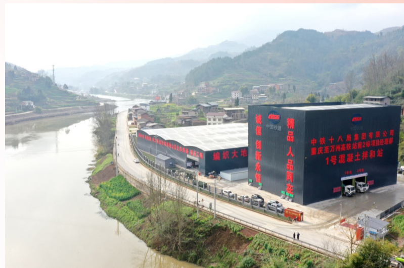
中铁18局渝万高铁站前工程2标1号混凝土拌和站建成投用。
