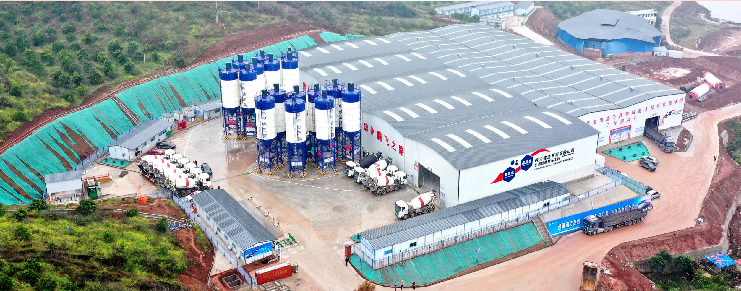
中铁3局渝万高铁站前工程3标2号拌和站、钢构厂主体工程完工。
