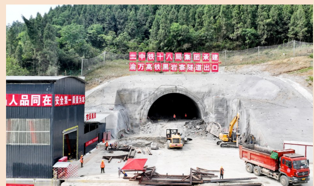
黑岩寨隧道施工现场
