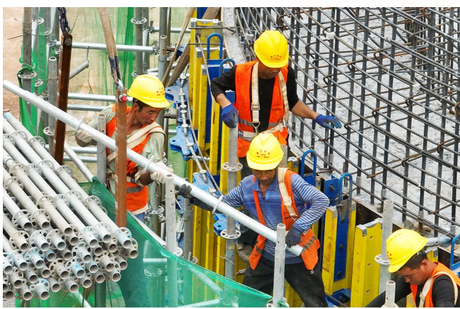
桥梁墩身施工
