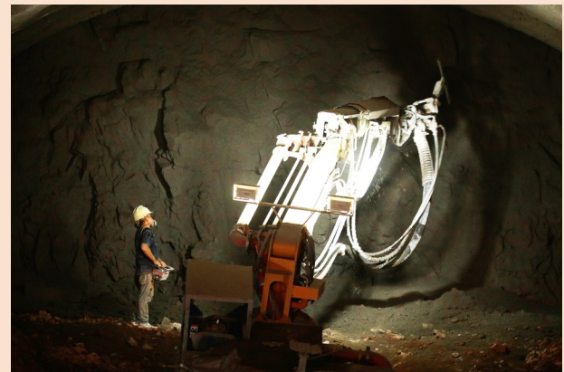
隧道施工精益求精
