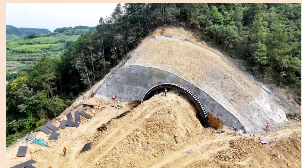
巴山村隧道施工现场
