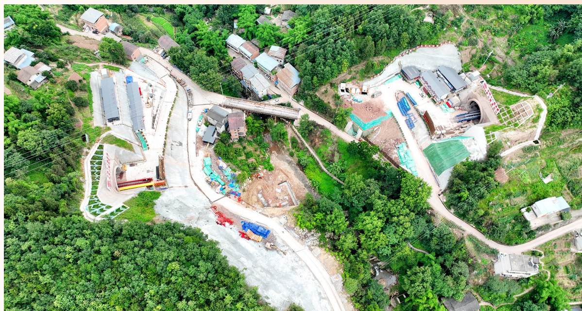
俯瞰任家山隧道(左)、香山隧道(右)施工现场
