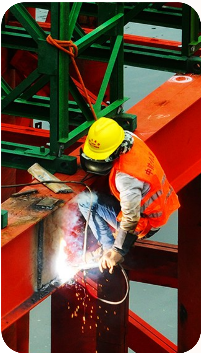
桥梁栈道和平台施工
