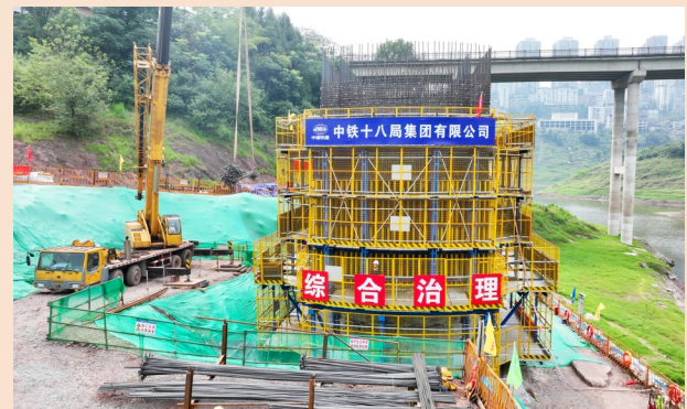
南溪河双线特大桥施工现场
