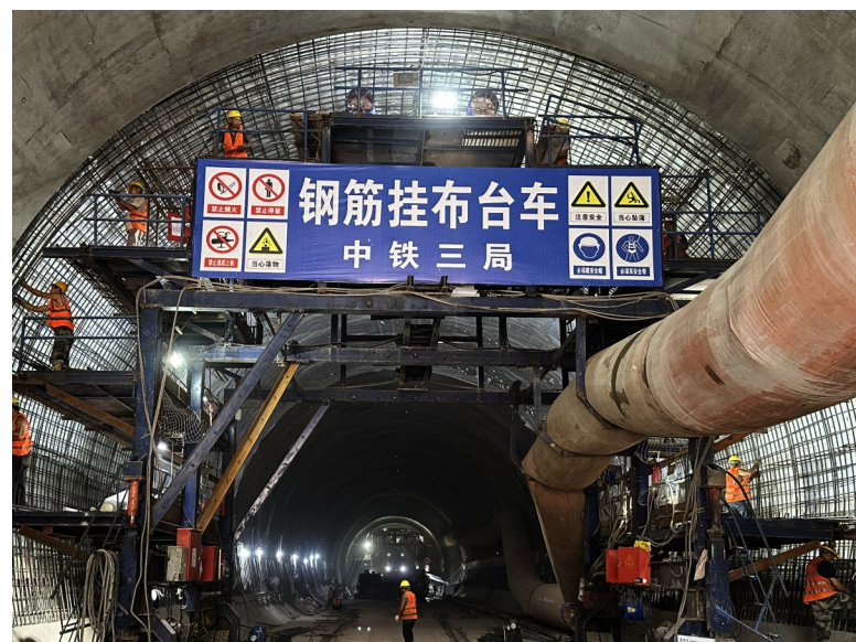
图为紧张建设中的任家镇隧道
