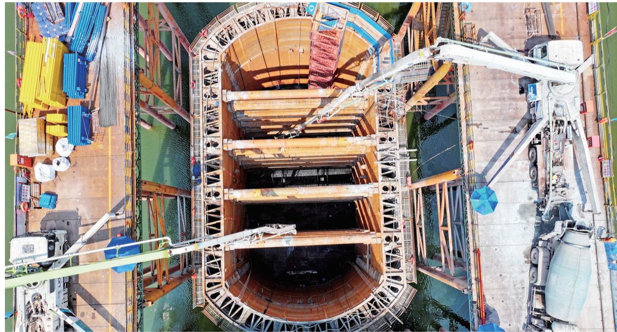
管井河双线特大桥7号主墩承台浇筑施工。记者赵军摄
