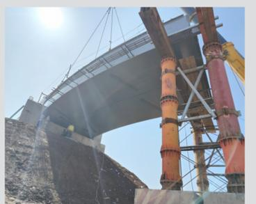
10月23日,G50沪渝高速公路忠县南收费站改造工程F匝道桥的上部结构钢箱梁开始吊装施工。
