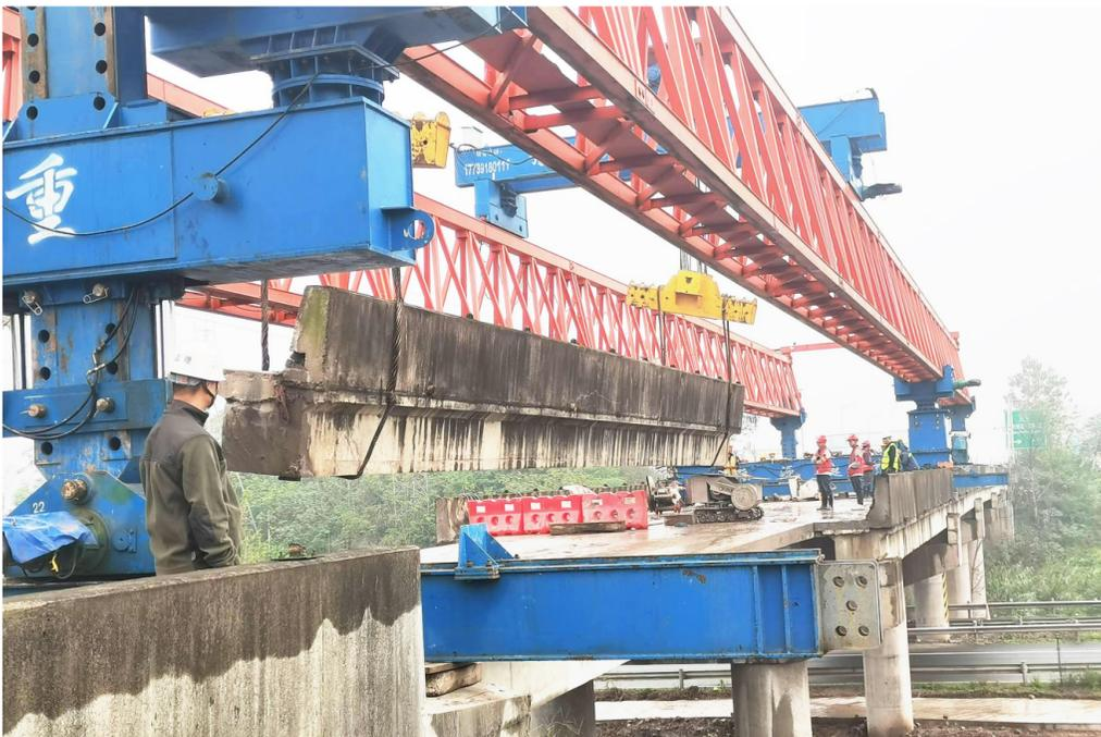
11月14日,作为G50忠县南收费站改造项目的一部分,忠信大道上跨沪渝高速公路车行天桥拆除工程开始拆除。截至目前,已完成拆除、吊运12片箱梁。
