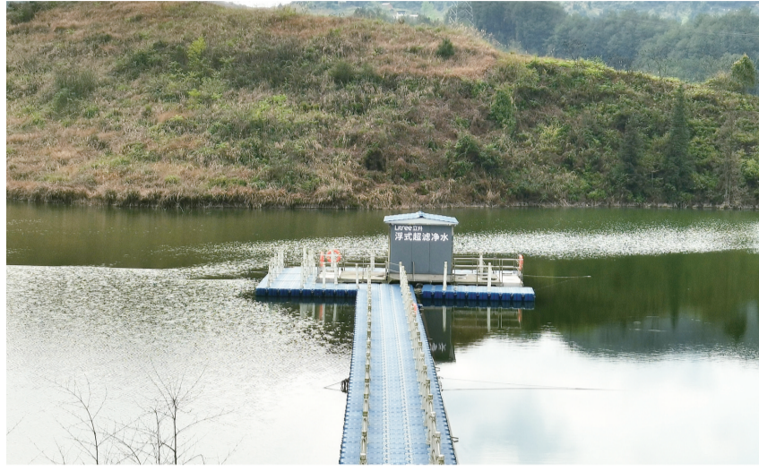
在采用超滤膜处理工艺制水技术基础上建成的浮桥式水厂。县水利局 供图
