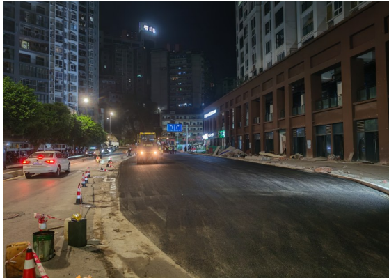
该路段完成沥青混凝土铺筑。
