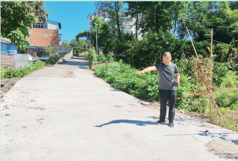
橘园小区新建的消防通道。
