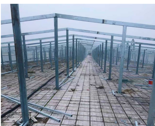
已完成安装的光伏板支架
