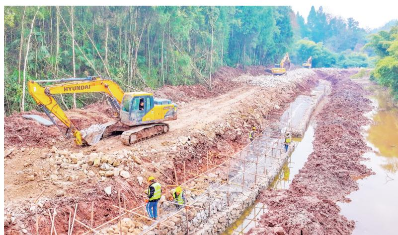
近日,在忠县永丰镇观桥村渠溪河流域治理现场,挖掘机与施工人员有序配合,将石块填充到金属丝网制成的格宾笼,然后码放成墙形成护堤。
