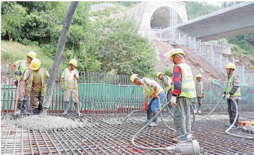
工人在紧张施工。
